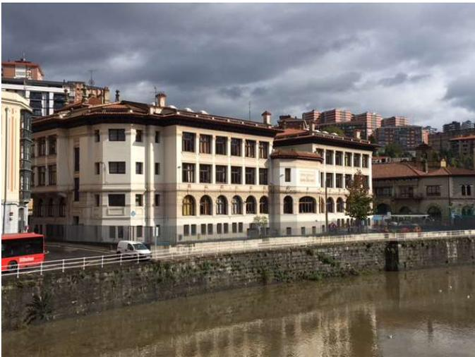
La escuela está constituida por un sólo edificio con cinco plantas y un espacio central con tres plantas. Una planta bajo rasante (la planta semisótano) y cuatro plantas sobre rasante. Hay un eje de simetría en medio del edificio que lo divide en dos crujiás simétricas.
